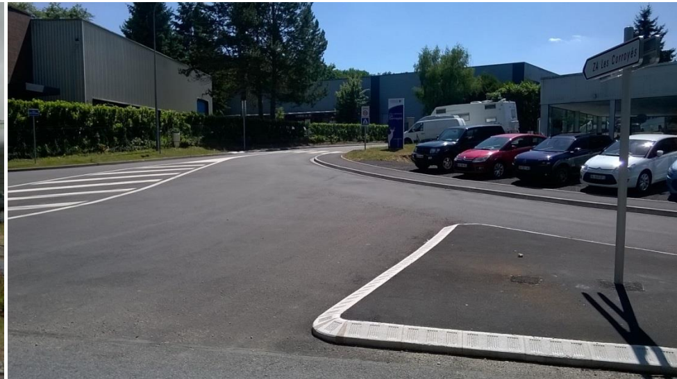
Après les travaux
