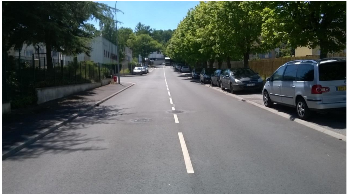
Après les travaux
